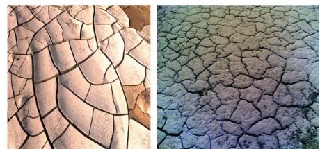
شکل ۲- خشک کردن کف استخر در زمان آماده‌سازی
