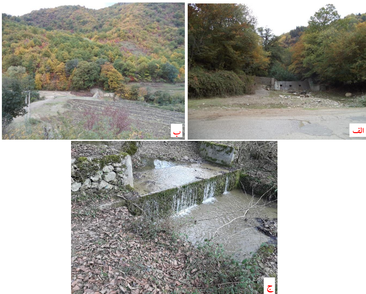
شکل ۲- نمونه‌هایی از انجام عملیات آبخیزداری در قسمت بالادست جاده‌های جنگلی (الف- سنگ و سیمان ب- بند سنگ و سیمان ج- بند سنگ، سیمان و گابیون)
