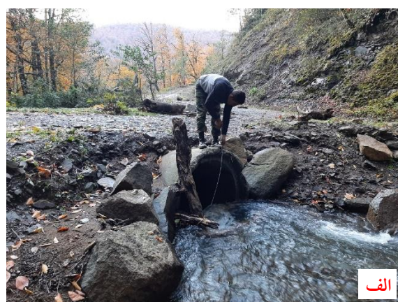
شکل ۱- الف و ب: تخریب و مسدود شدن آبروها در جاده‌های جنگلی در اثر سیل و رسوب‌گذاری
