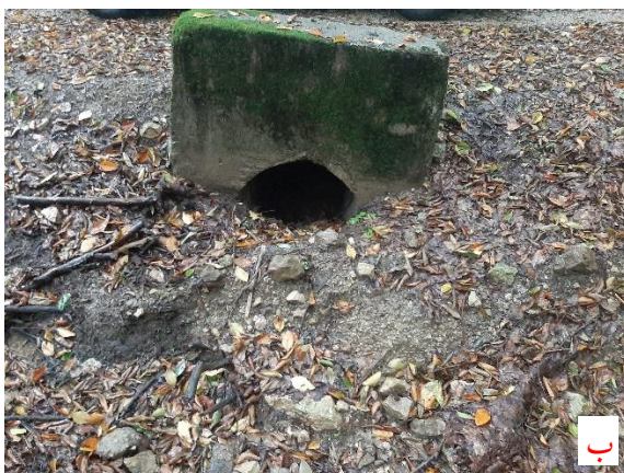
شکل ۱- الف و ب: تخریب و مسدود شدن آبروها در جاده‌های جنگلی در اثر سیل و رسوب‌گذاری
