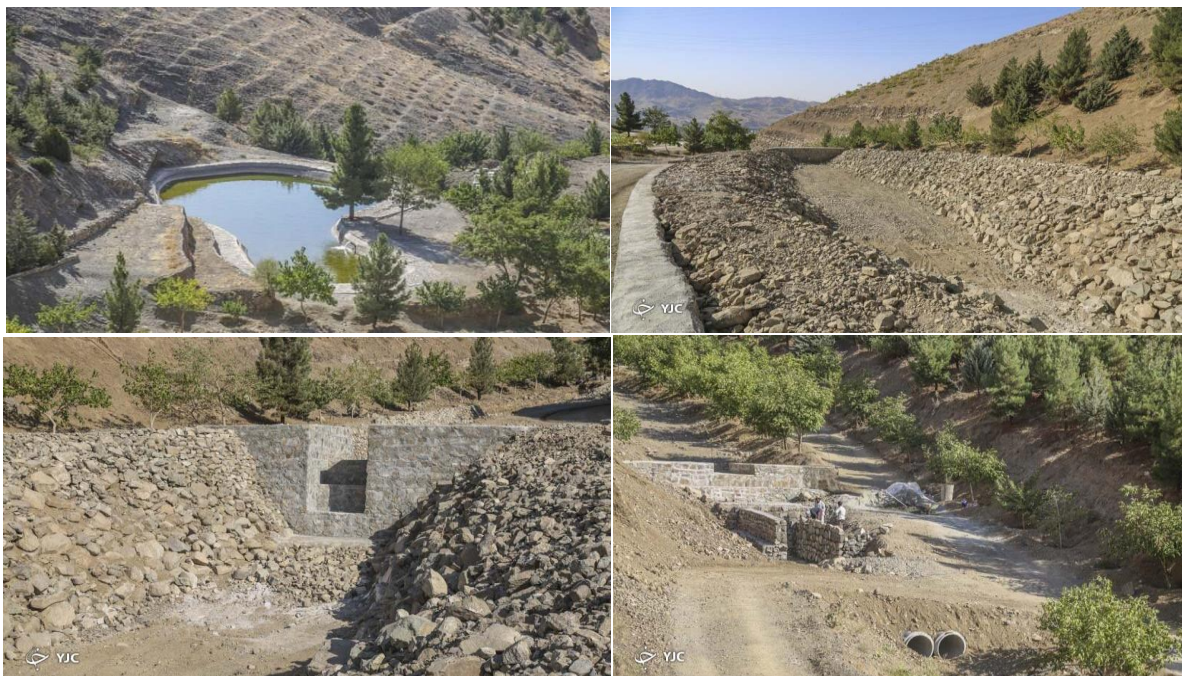
شکل ۴- تصاویری از اجرای عملیات مختلف آبخیزداری (بیولوژیک، بیومکانیک و مکانیک) در ارتفاعات و بالادست آبخیز شهری کرج
