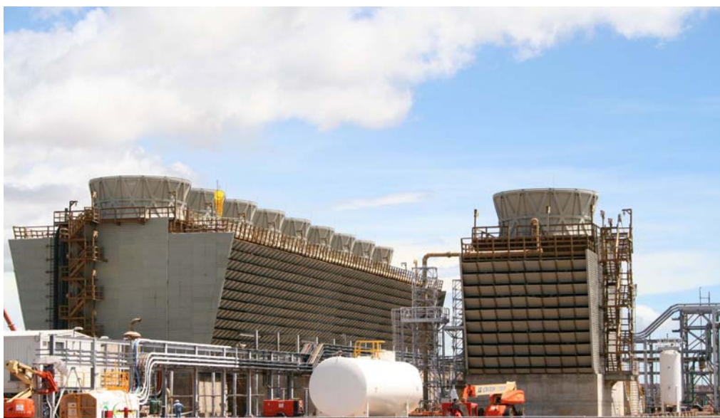
شکل ۳- برج خنک کننده با جریان عرضی
