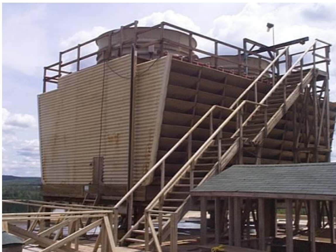
شکل ۴- برج خنک کننده با جریان عرضی
