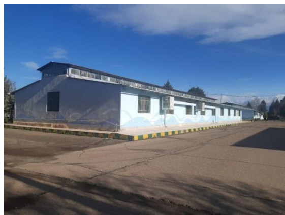
شکل ۳- نمایی از سطوح عایق (سقف سوله) در ایستگاه تحقیقاتی اسماعیل‌آباد
