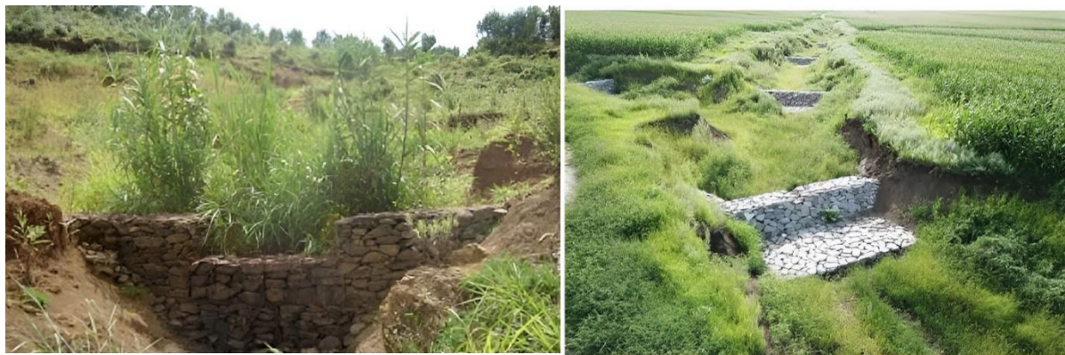
شکل ۴- مهار خندق با استفاده از روش ترکیبی در عرصه‌های طبیعی (Liu et al., 2019 & Addis et al., 2015)
