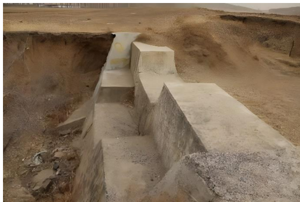
شکل ۳- مهار خندق به وسیله بند در عرصه‌های طبیعی (Liu et al., 2019)
