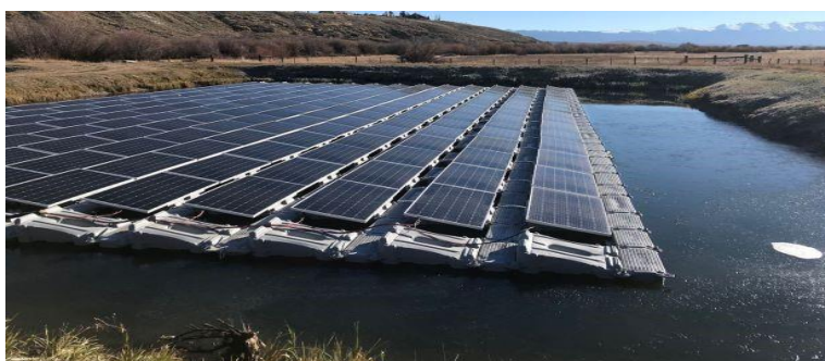
شکل ۲- کاربرد سامانه فتوولتائیک برای پوشش سطح استخر ذخیره آب کشاورزی و تولید انرژی
