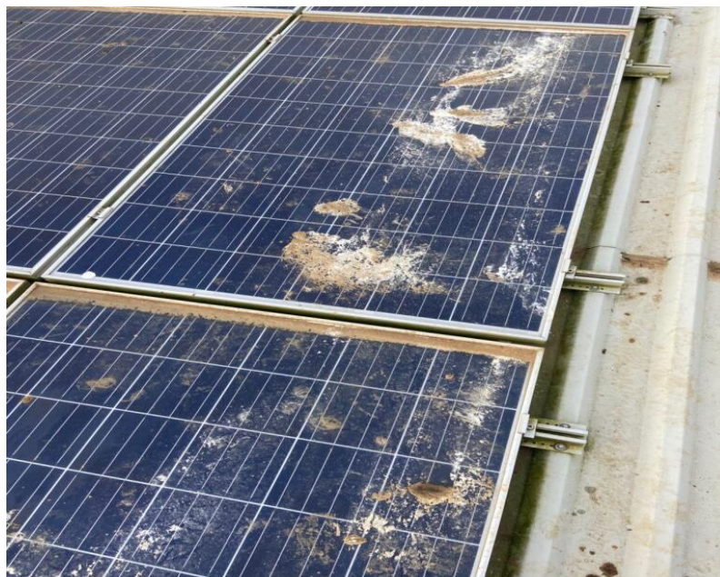
شکل ۴- نمونه‌ای از اثر فضولات پرندگان بر روی پنل‌های خورشیدی
