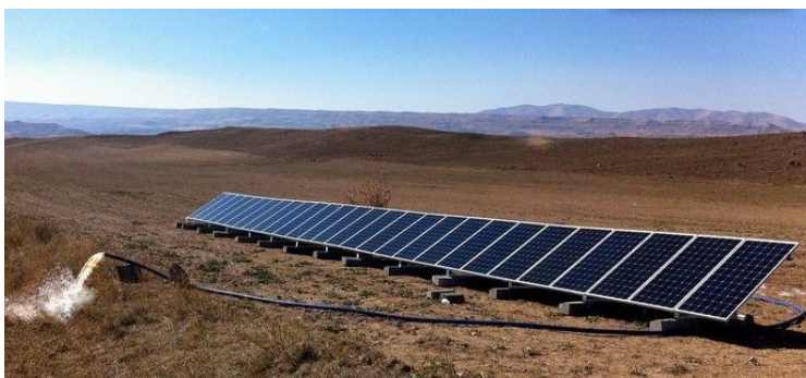
شکل ۱- نمونه‌ای از به‌کارگیری سامانه فتوولتاییک برای پمپاژ آب در استان قم
