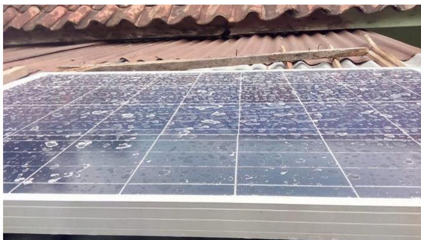
شکل ۵- نمونه‌ای از باقیمانده نمک و املاح بر روی پنل
