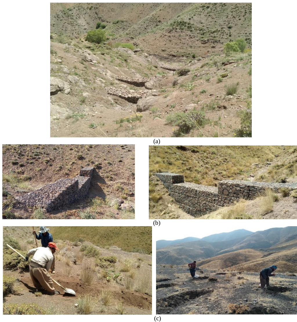
شکل ۲- تصویری اقدامات اجرایی از سازه‌های خشکه‌چین (a)، سازه‌های گابیونی اجرا شده (b) بانکت‌بندی و بذرکاری در داخل بانکت‌بندی (c) در حوزه آبخیز نمونه (منبع تصاویر: نویسندگان)
