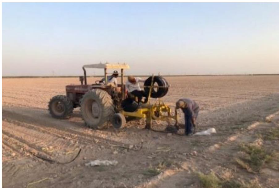
شکل ۱- لوله گذاری با استفاده از دستگاه لوله گذار در مزرعه آبیاری قطره ای زیرسطحی Figure 1- Pipe laying using a pipe laying device in a subsurface drip irrigation field
