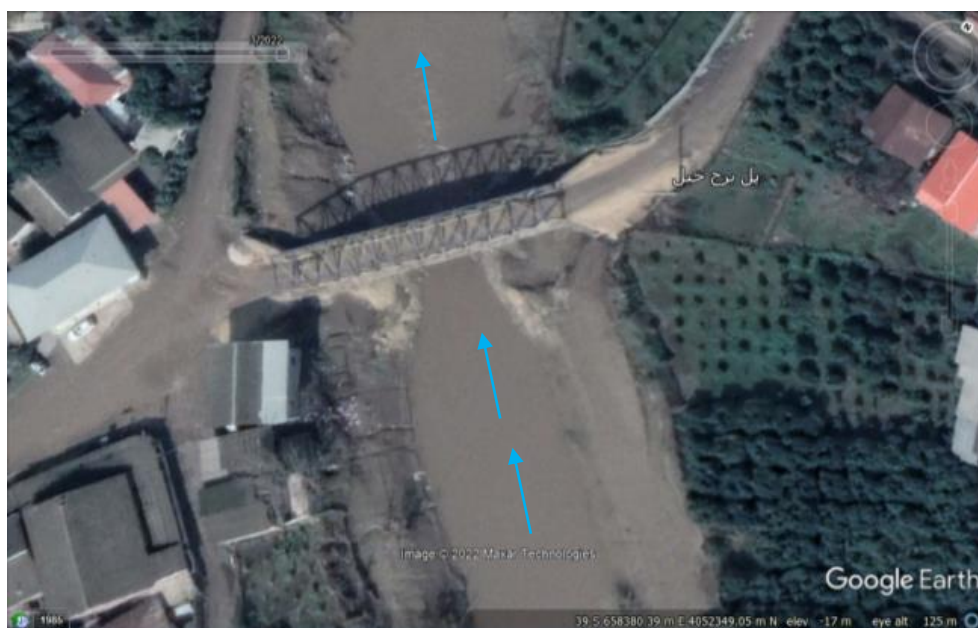
شکل ۷- تصویر گوگل ارث از پل جدید برج خیل پس از وقوع سیل اسفند
