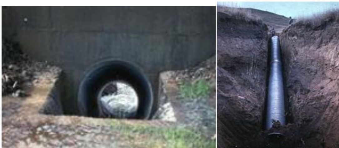
شکل ۱۲- انتقال رواناب سطحی از بالادست پیشانی به درون آن با احداث حوضچه جمع‌آوری و لوله گالوانیزه (Kautz و Aull، ۱۹۷۱)
