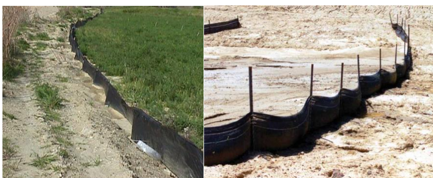
شکل ۴- دیوارهای برزنتی کنترل رواناب سطحی و رسوب
