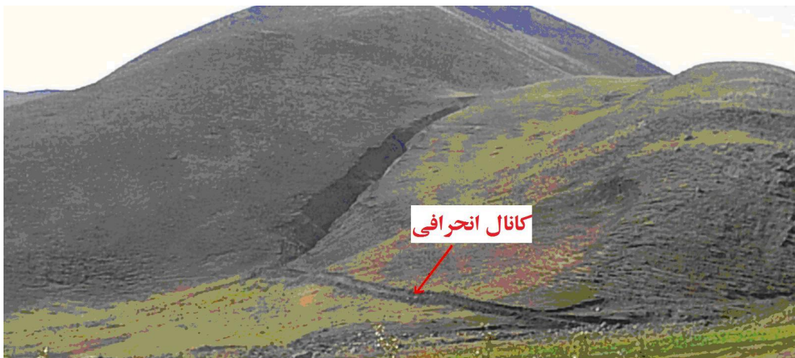
شکل ۱۰- مدیریت آبکند با احداث کانال انحراف رواناب سطحی در روستای تغنیت آذربایجان غربی
