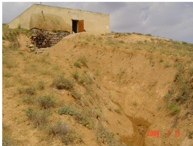
شکل ۳- ایجاد آبکند بر روی یک تپه پر شیب در اثر سرریز آب از منبع احداث شده در بالای شیب-استان زنجان
