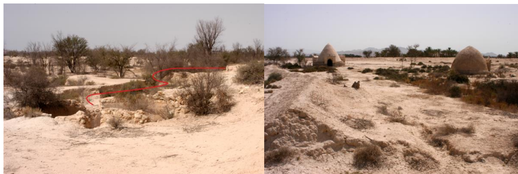
شکل ۷- تخریب آب‌انبارها در روستای گزیر بندرلنگه سبب ایجاد آبکند در مسیر حرکت رواناب سطحی شده است
