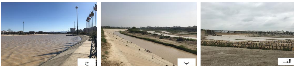
شکل ۸- الف) ایجاد پوشش کناره سنگ‌چین در بازه ۵، ب) ایجاد پوشش بتنی کناره در بازه ۵ و ج) کانال‌سازی جریان و از بین رفتن پوشش گیاهی در بازه ۵
