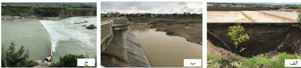
شکل ۷- الف) شیب‌شکن و پوشش بستر در بازه ۶، ب) سد انحرافی و راه ماهی در بازه ۵ و ج) سازه شیب‌شکن در بازه ۳
