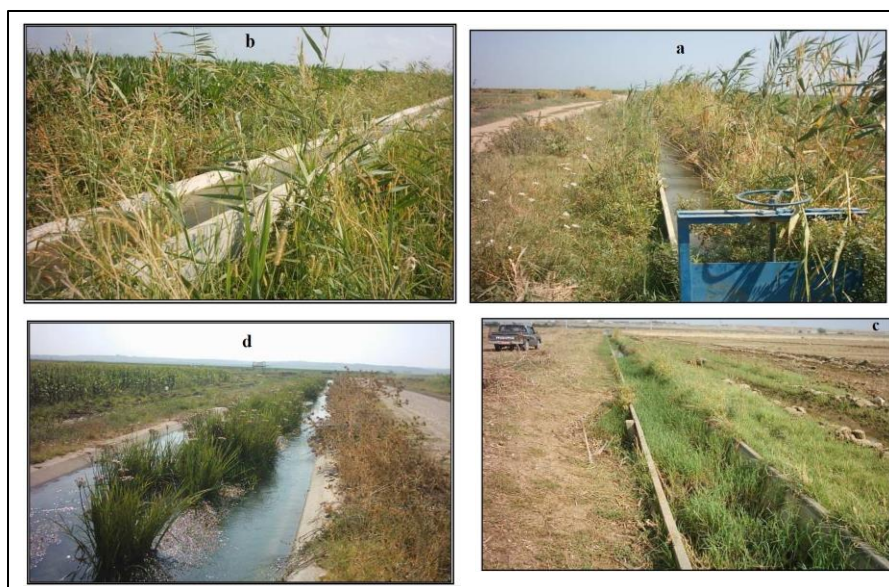
شکل ۶- رشد علف هرز در حریم کانال پیش‌ساخته بتنی (a و b)، در داخل کانال پیش‌ساخته بتنی (c) و کانال درجه ۲ بتنی (d)
