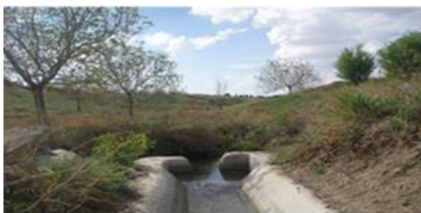
شکل ۴- نمایی از ورودی کانال انتقال آب
