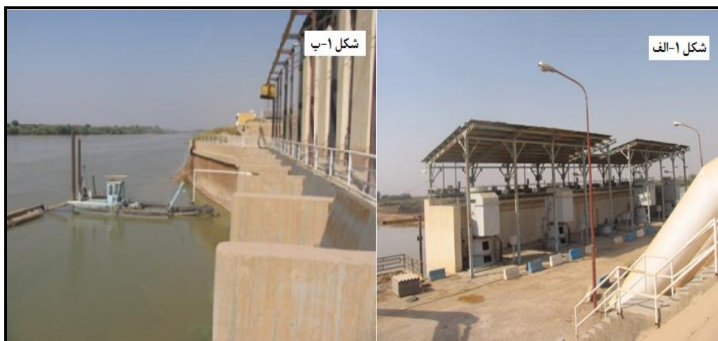
شکل ۱- الف) نمایی از ایستگاه پمپاژ ویس، استان خوزستان و ب) لایروبی دهانه آبیگر به دلیل رسوب‌گذاری ورودی دریچه‌های آبیگر
